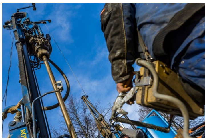
Geothermiebohrung für Wohnquartier in Berlin
