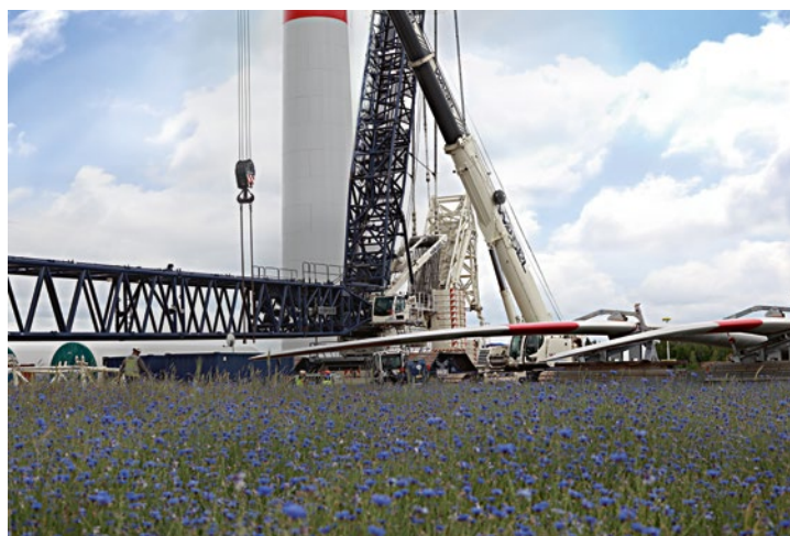
Windpark Mallnow im Bau im Osten Brandenburgs
